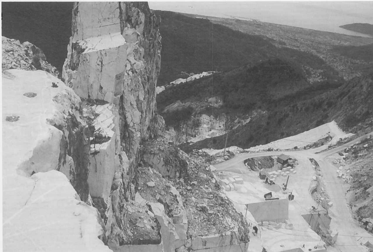
Fig. 2 - Fronte di escavazione ( tecchia ) abbandonato. Visibile la fascia di intensa fratturazione ( finimento ) ed il piazzale di lavorazione sottostante.
