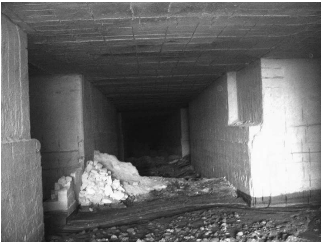
Fig. 2 - Particolare delle cave in sotterraneo di calcarenite.
