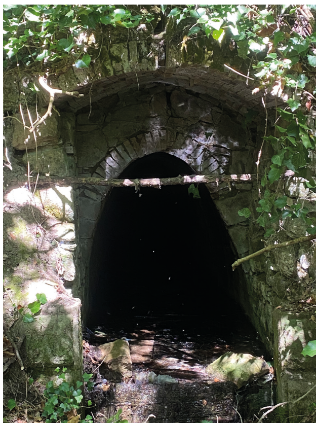
Figura 11. Ingresso in muratura della galleria Guglielmo (foto dell'autore).
