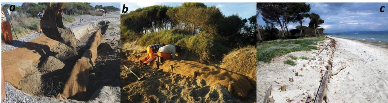
Figura 4. Esempio di protezione/formazione dell'anteduna con bioreti in fibra di cocco: a) fase costruttiva; b) fase di completamento dell'intervento; c) alcuni mesi dopo l'intervento.
