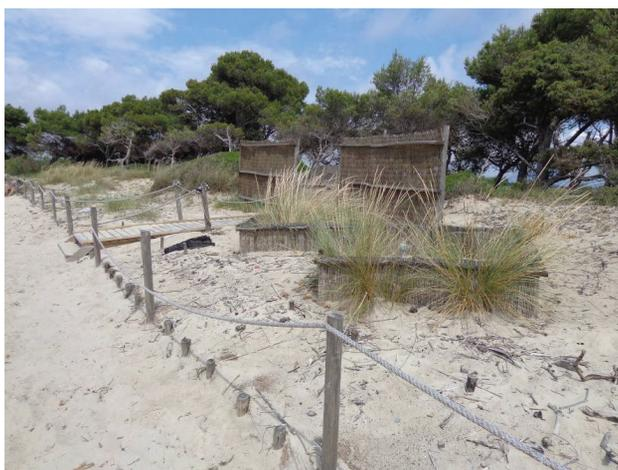
Figura 3. Morfologia dunale naturalmente ricostruita a monte del cordone antedunale in bioreti, associato alla realizzazione di celle di impianto di specie erbacee psammofile e di accessi attrezzati.
