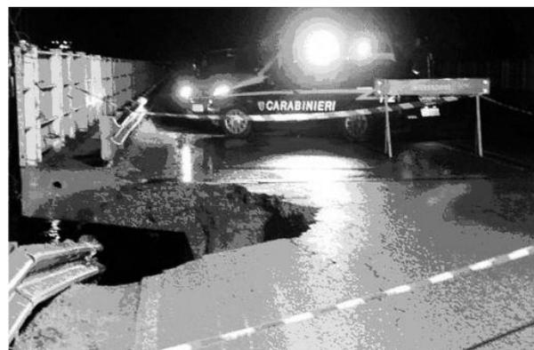
Fig. 7 - Crollo parziale del Ponte della Colombiera a seguito dell'alluvione.
