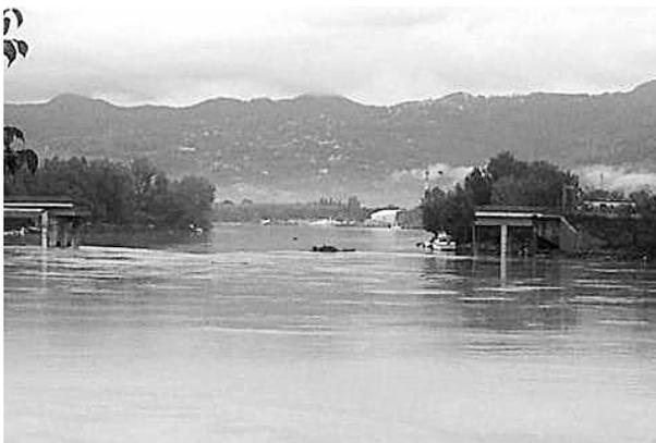
Fig. 21 - Ponte della Colombiera crollato completamente dopo l'alluvione del 25 ottobre 2011.
