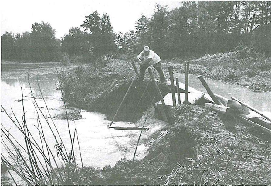
Fig. 4 - Rottura arginale del "Fossone di Millo" a S. Maria a Colle (22/9/1994).
